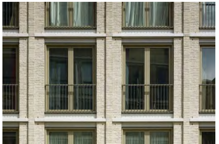
HESSENBERG, NETHERLANDS, HANS VAN DER HEIJDEN ARCHITECTS
